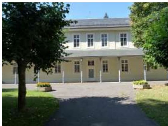
Bâtiment ESQUIROL au CHS de la Savoie, abritant la Bibliothèque Professionnelle
