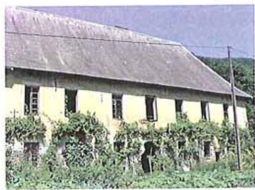
Bâtiments du Betton dans leur état actuel
